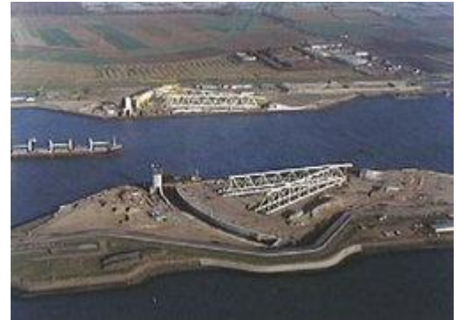
Maeslantkering (bron: beeldbankvenw.nl Rijkswaterstaat)
